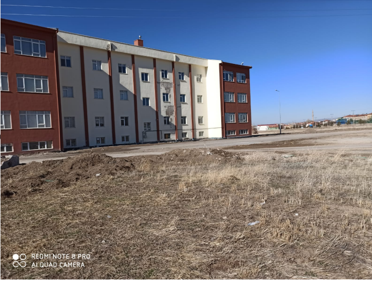
Bahçe Duvarı ve Mantolama yapılması gereken alan
