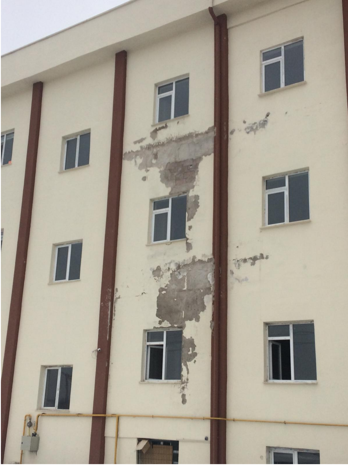
Mantolama ve dış cephedeki hasarların giderilmesi planlanmaktadır.
