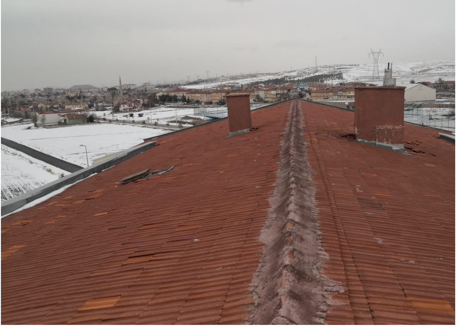
Çatı katı tamir ve bakımı yapılması planlanmaktadır.
