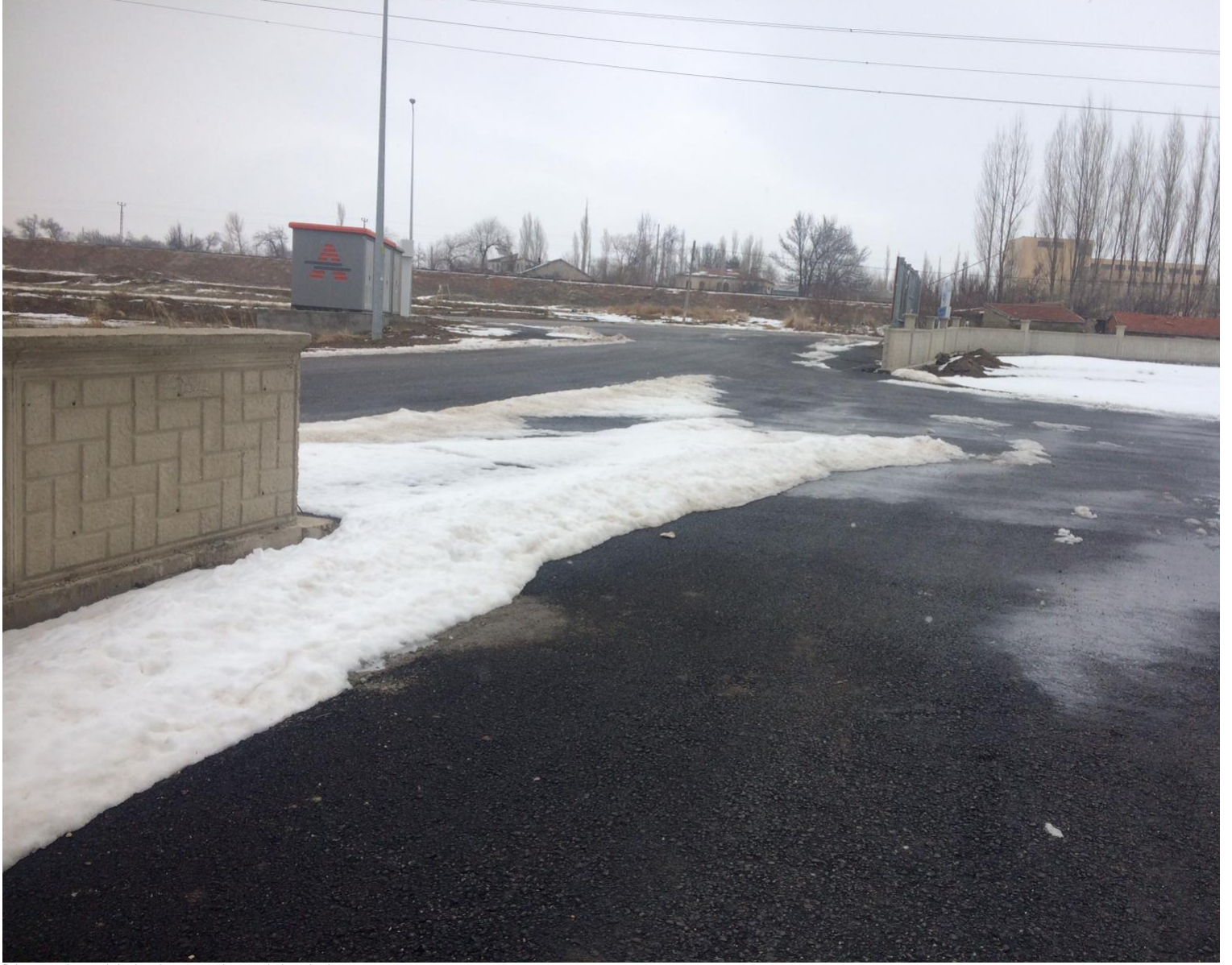
Bahçe çevre duvarının kalan kısımlarının tamamlanması planlanmaktadır.
